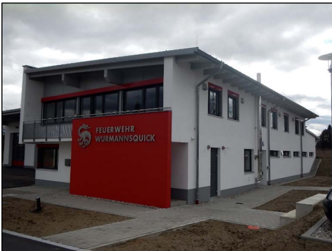
Abbildung 10: Umkleiden im EG, Schulungsraum im OG
