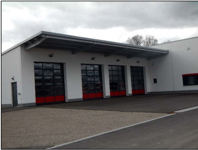
Abbildung 9: Unterstell-/Waschhalle für die Fahrzeuge
